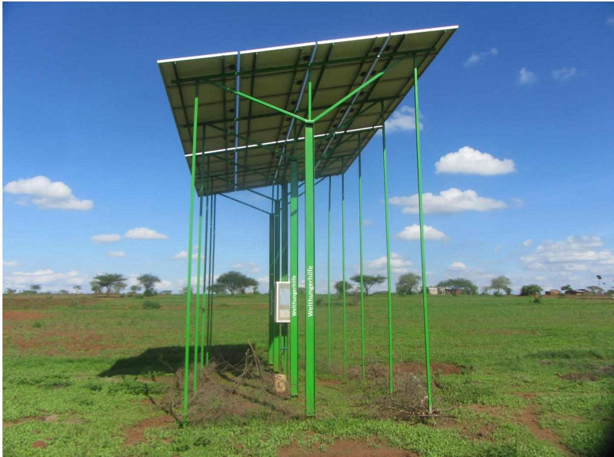
*Installierte Solarmodule des Katangini-Wasserprojekts zur Energieversorgung der Brunnenpumpe*
